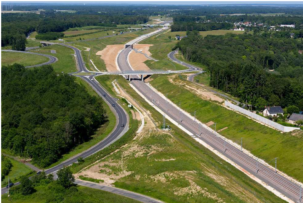
Figure 50 : Ecran et merlon acoustiques à Veigné, au Lieu-dit Thorigny.
