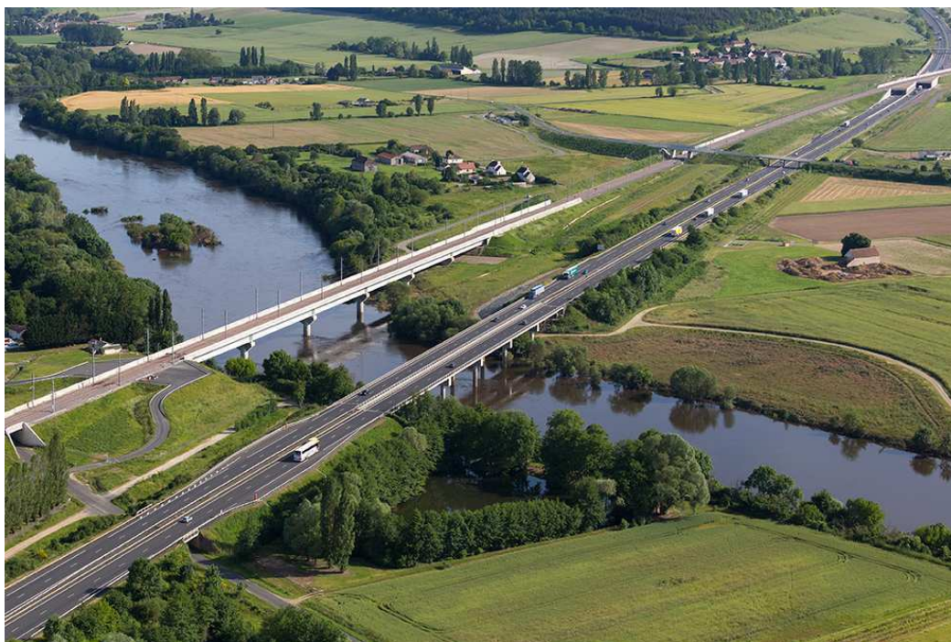
Figure 51 : L'autoroute A10 au passage de la Vienne au premier plan.
