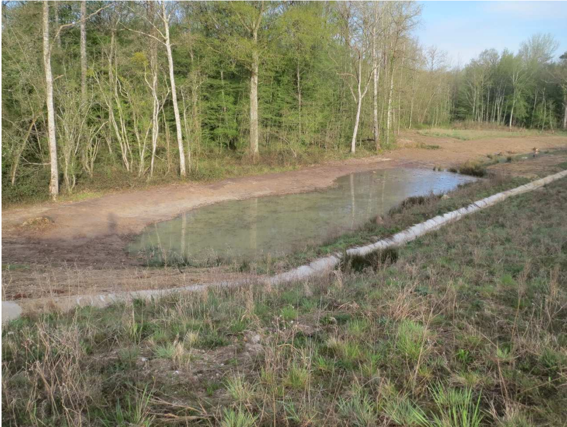
Figure 3 : Réalisation d'une mare de substitution sur la commune de Monts (37)
