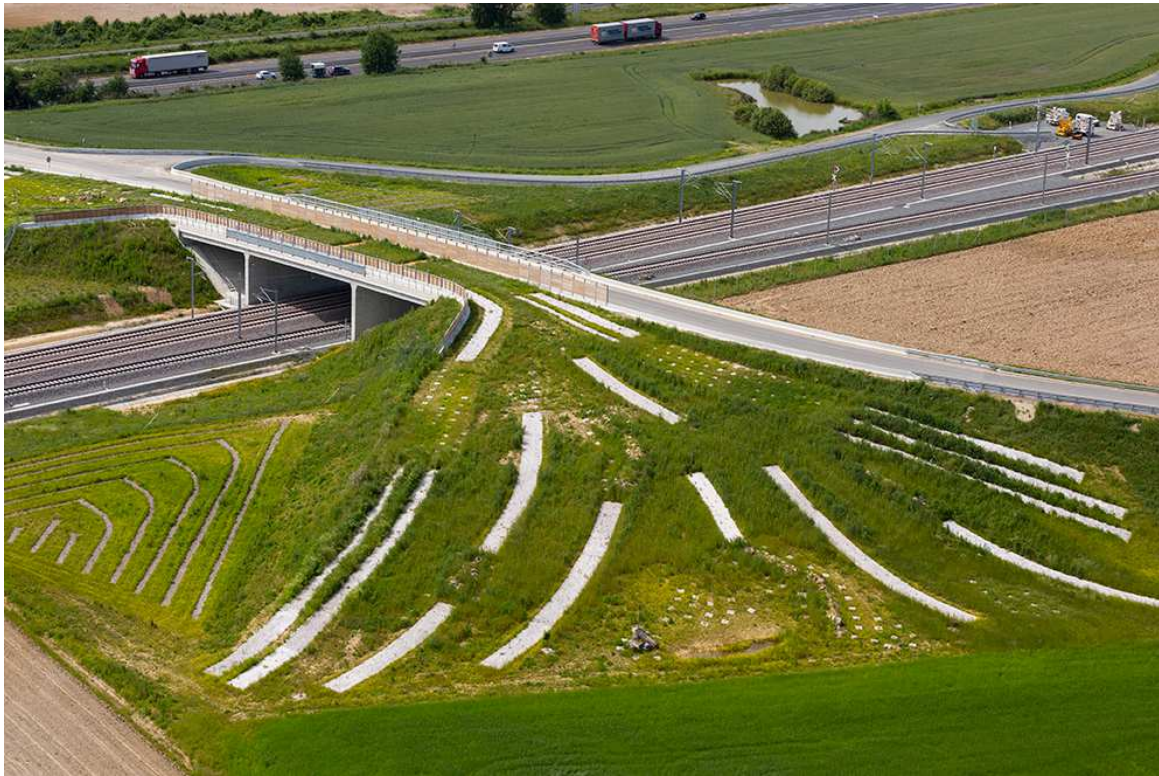
Figure 6: Passage spécifique pour la grande faune (Commune de Sorigny dans l'Indre-et-Loire, prise de vue juin 2016).
