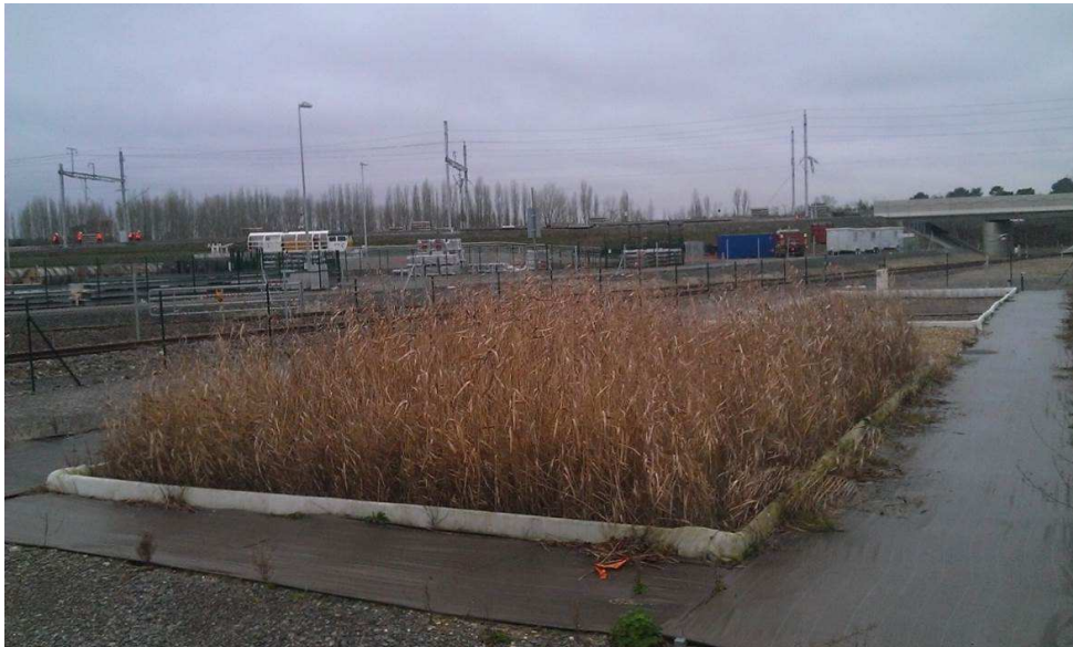
Figure 77 : Station d'épuration à lits de roseaux de la base de Nouâtre-Maillé
