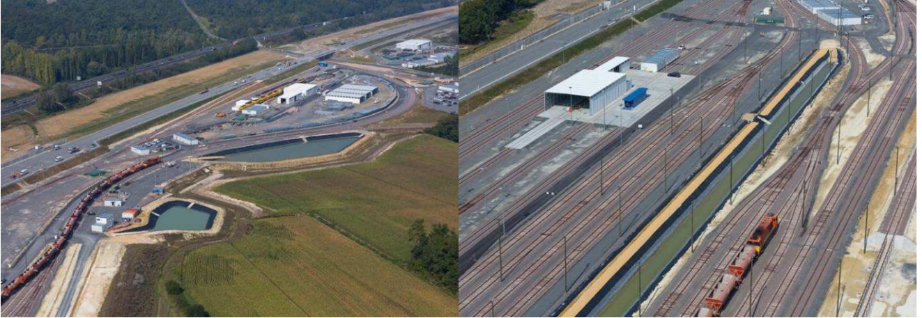
Figures 78 et 79 : Bassins d'assainissements permettant la décantation des eaux de ruissellement de la base travaux
