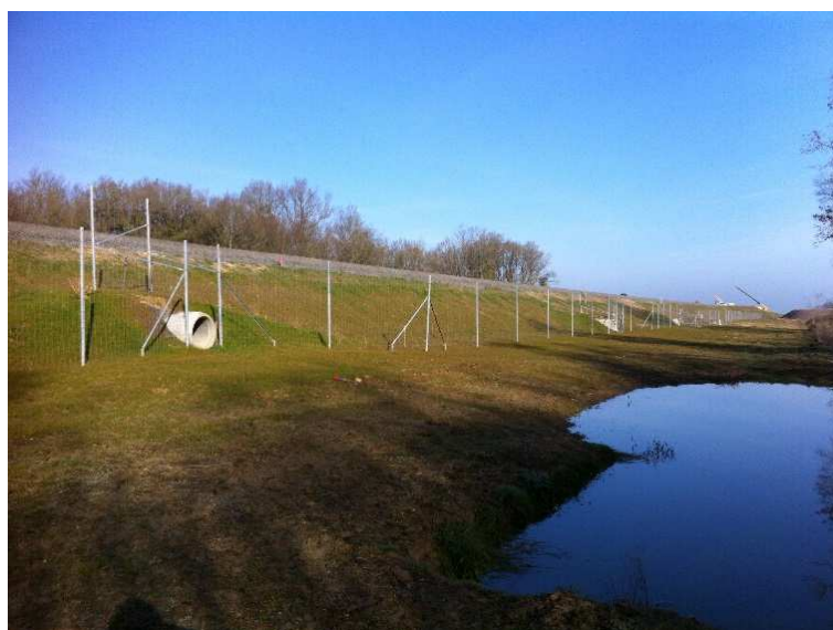
Figure 5 : Passage spécifique pour la petite faune et bassin réaménagé en mare (Commune de Sainte Catherine de Fierbois dans l'Indre-et-Loire, prise de vue mars 2015).
