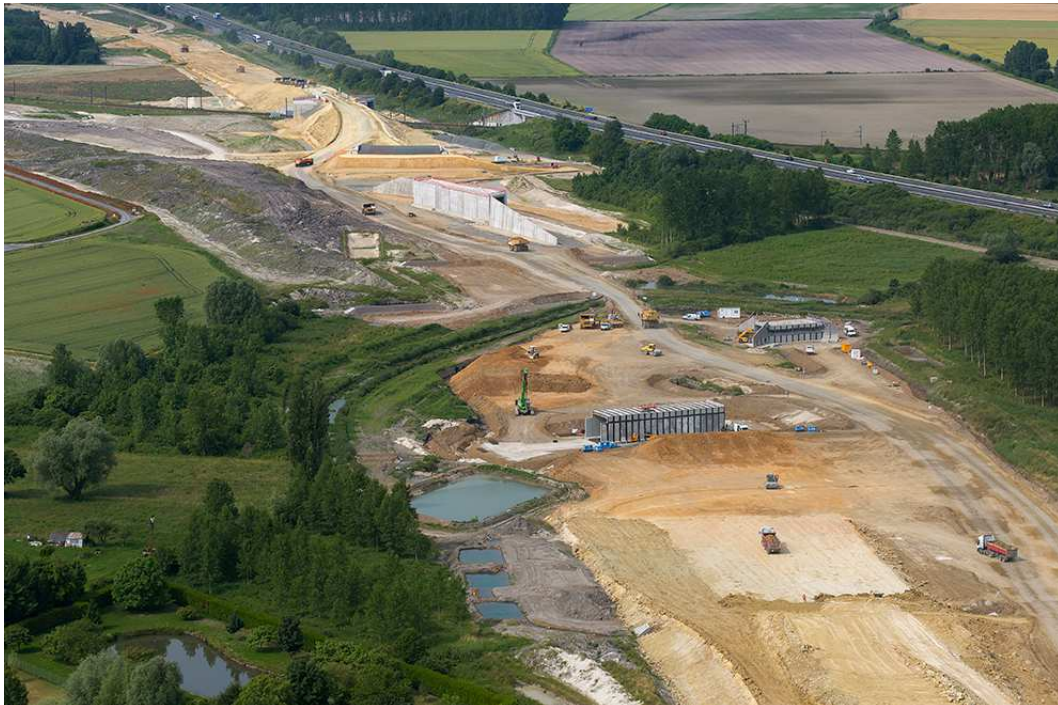
Figure 63 : Fossés et bassins provisoires protégeant le ruisseau du Réveillon (Commune de Maillé Indre-et-Loire, prise de vue juin 2013).
