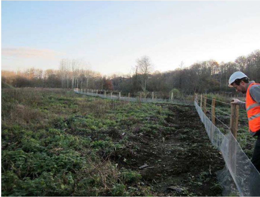
Figure 4 : Pose des clôtures provisoires de l'emprise de travaux
