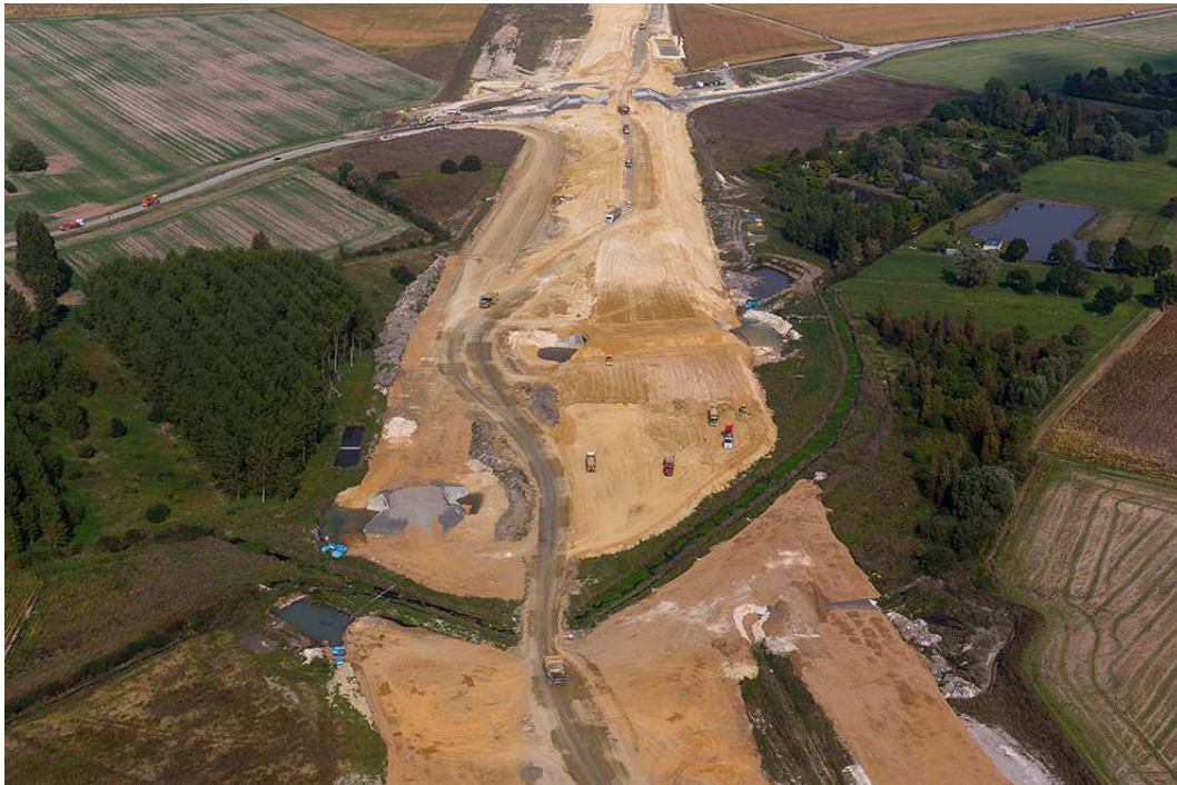
Figure 6 : Exemple de maintien du corridor en phase de travaux - prise de vue septembre 2013.
