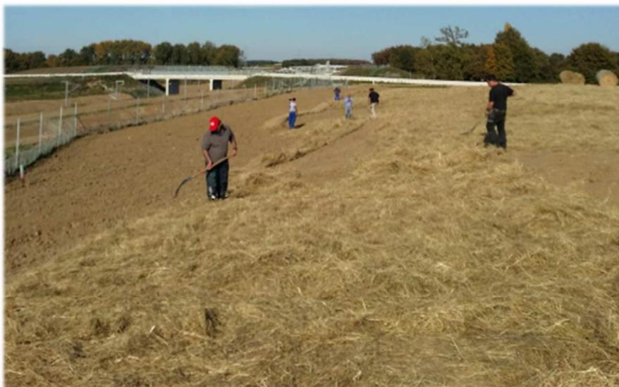
Figure 16 : Réalisation d'un semi pour favoriser la reprise végétale
