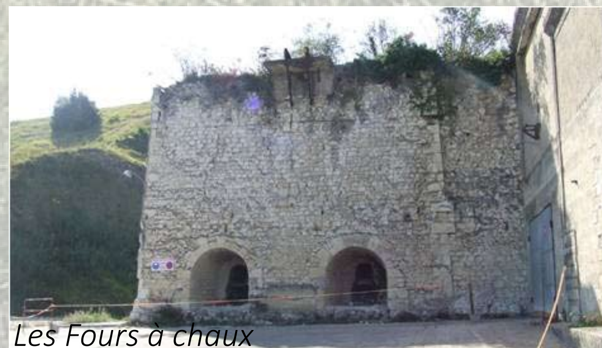
Les Fours à chaux
